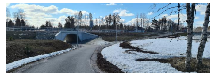
Kuva 13: Koivukuja johdattaa tunneliin, jonka kautta pääsee Rovaniementien ali pyörällä ja jalan.
