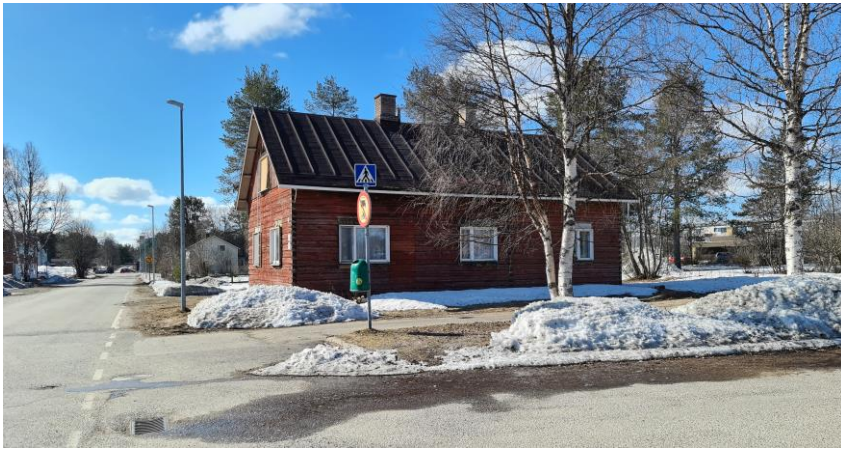
Kuva 34: Ojennustiellä sijaitsee hirsitalo, joka siirretään pois.
