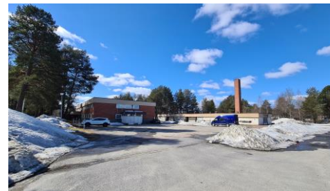
Kuvat 45-47: Sijaintivaihtoehdossa sijaitsee kolme rakennusta, joista kahdessa on I-II kerrosta ja tasakatto
