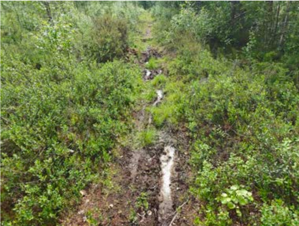
Mätkää maapohjaa Pyhäjoen ja Mairivaaran välisellä osuudella.
