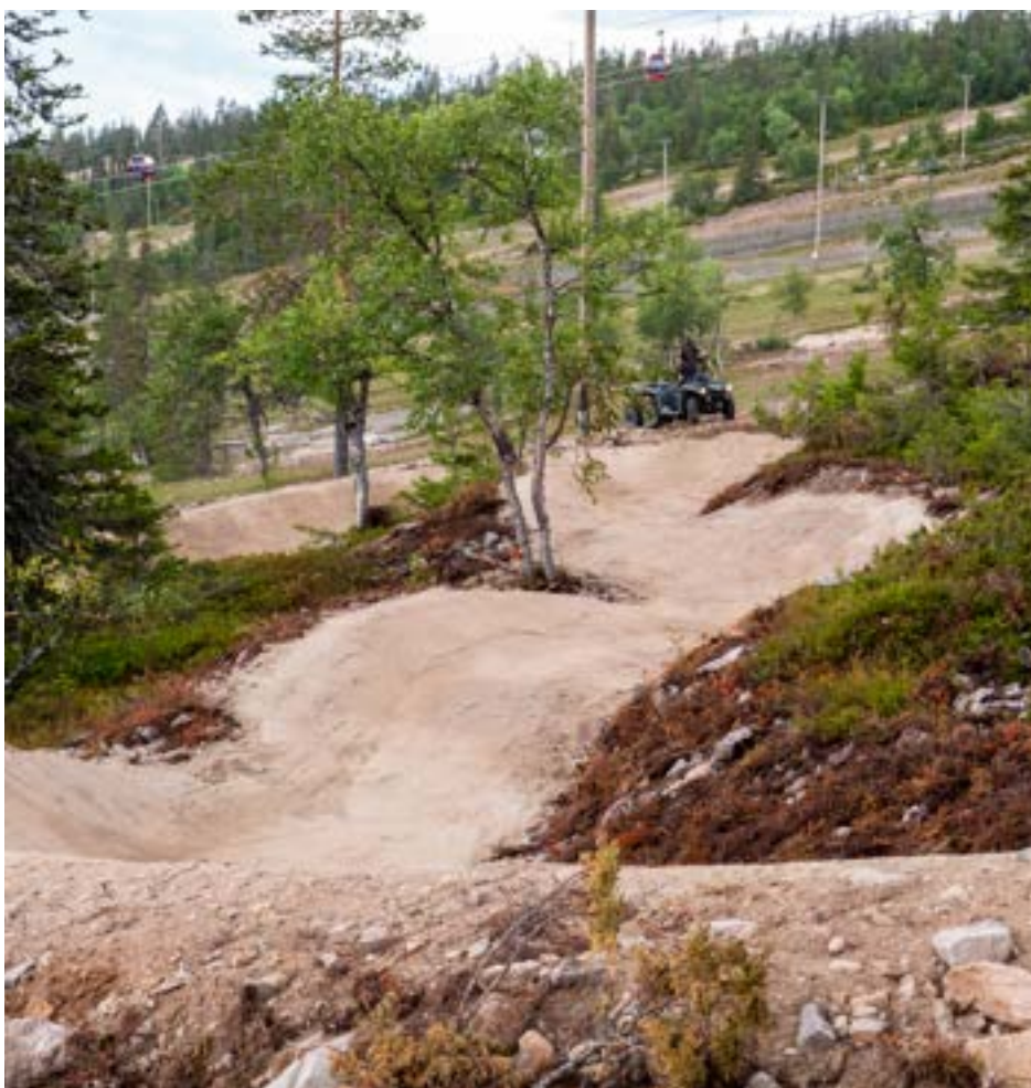
Koneellisesti paikallisesti maasta rakennettu
