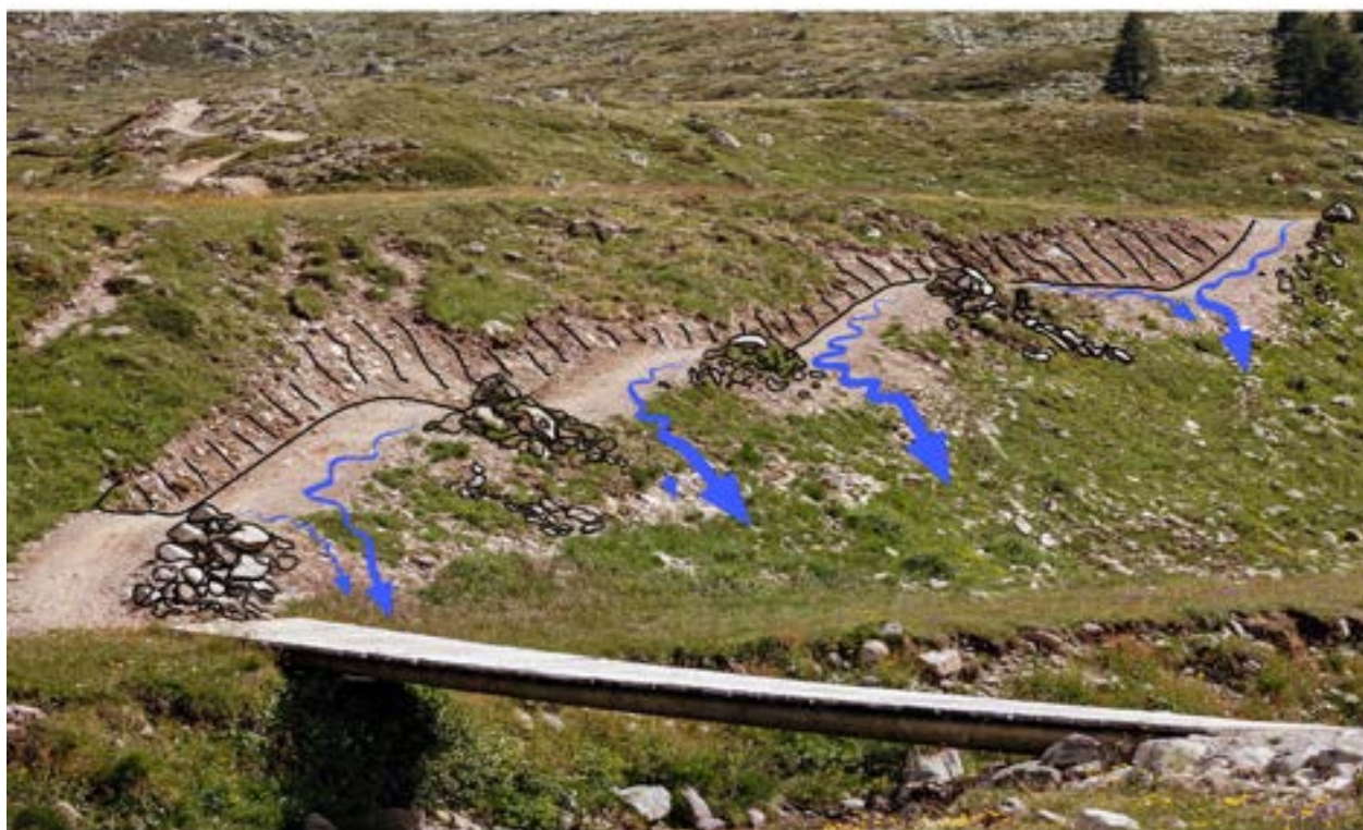
Reitin kaltevuusvaihtelulla lisätään ajamisen hauskuutta ja ohjataan vesi tehokkaasti pois reitiltä
